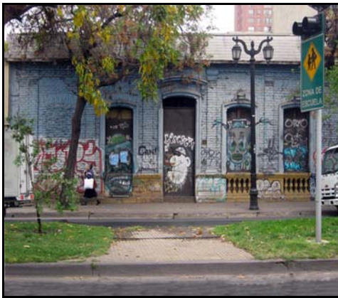
Fotografía de fachada
