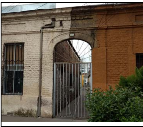
Fotografía de fachada
