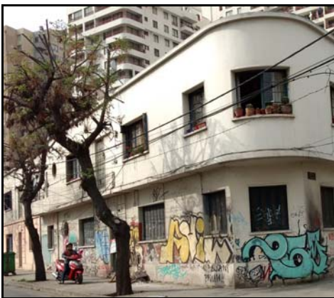
Fotografía de fachada
